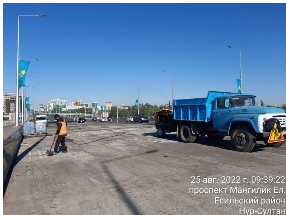
7-сурет - Беткі қабатты тазалау процесі
