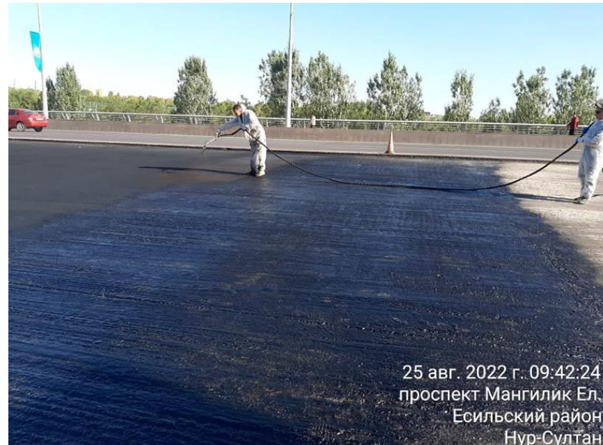
9-сурет - «А» және «В» құрауыштарының екінші қабатын жағу
