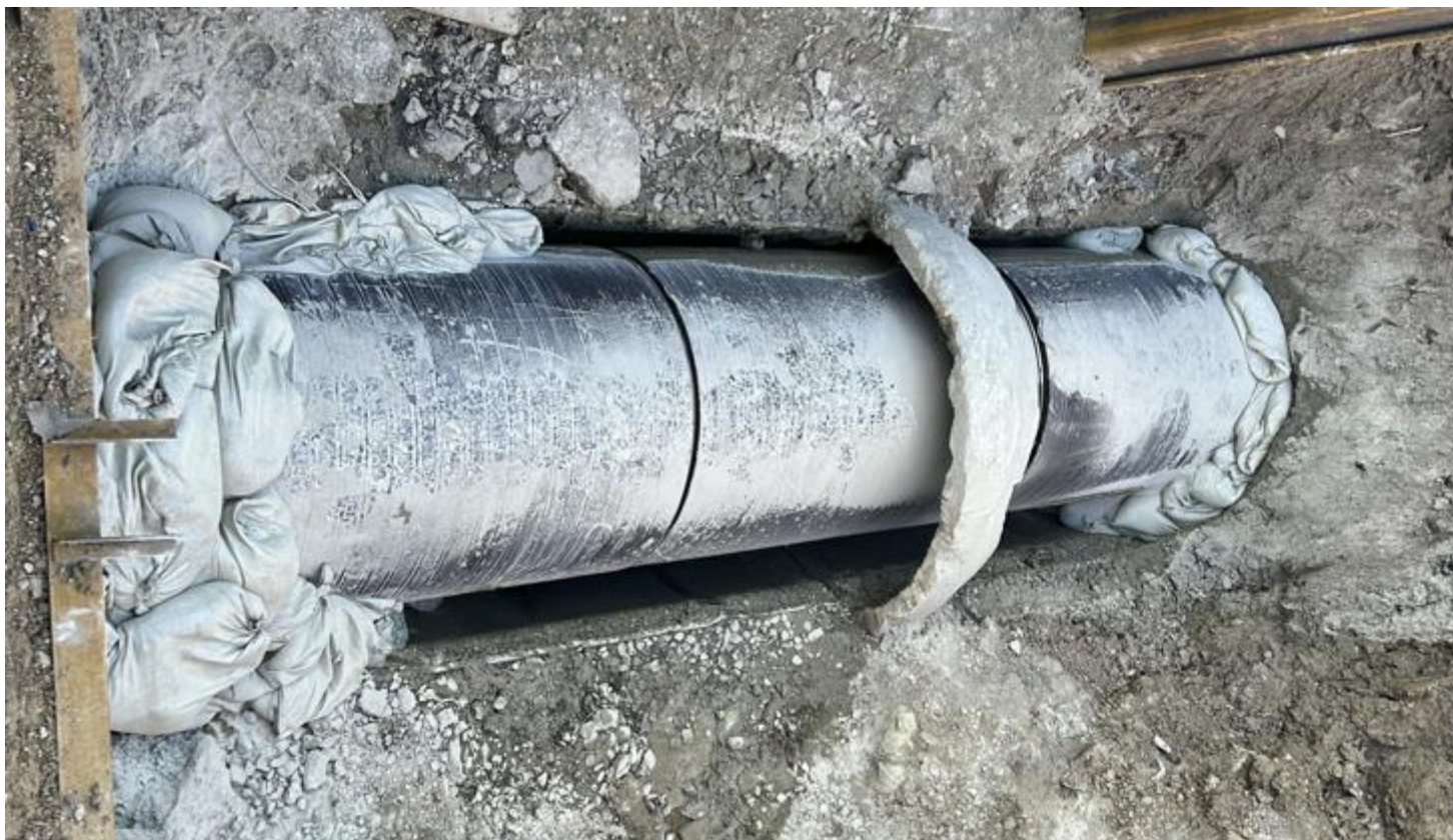
2.11-сурет - Қазаншұңқырлар шегінде т/б құбыр тоғыспасын герметикалау
