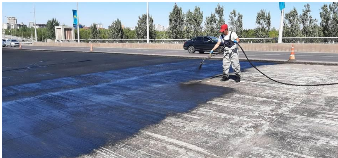
8-сурет - «А» құрауышының бірінші қабатын жағу
