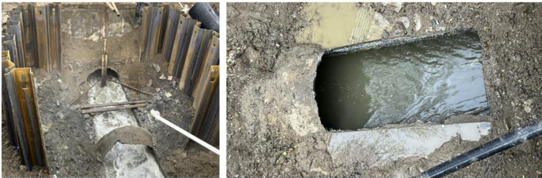
2.1-сурет - Қазаншұңқырдағы құбырдың жоғарғы бөлігін бөлшектеудің технологиялық схемасы
